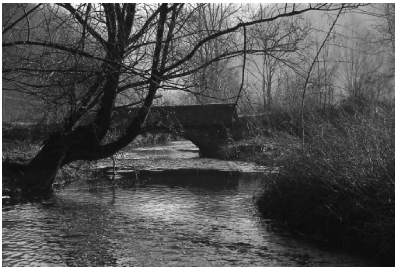
Il corso del Seveso tra le colline comasche (foto A. Pozzi)
